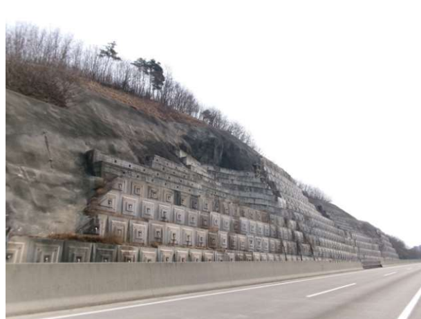
6공구 패널식 옹벽 10
