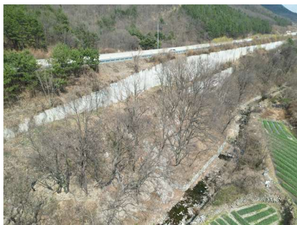
3공구 패널식 옹벽 01
