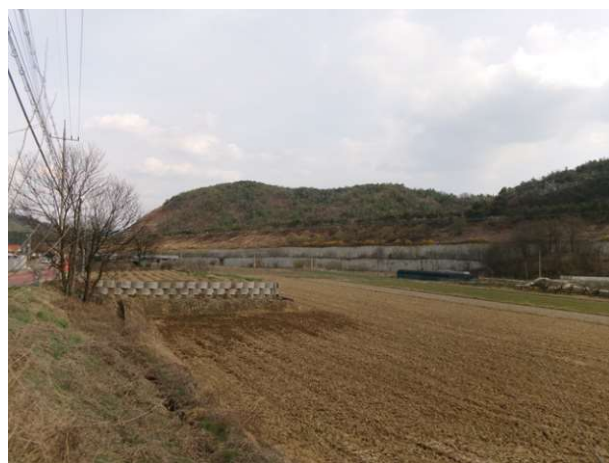
3공구 패널식 옹벽 02
