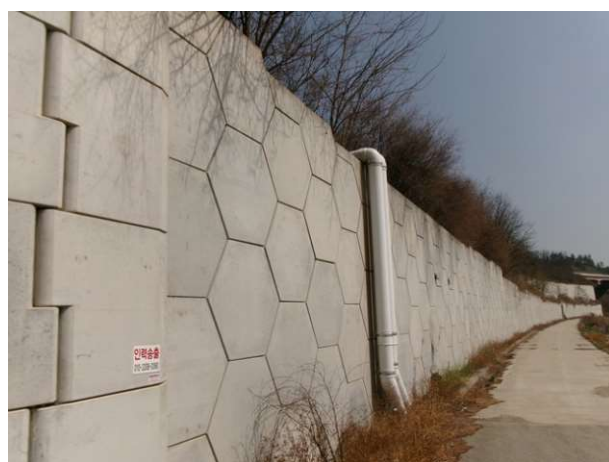
7공구 패널식 옹벽 12
