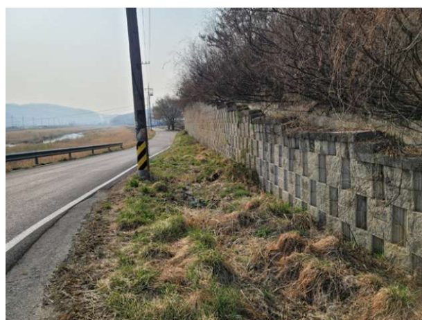
5공구 블럭식 옹벽 06
