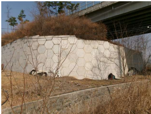
9공구 패널식 옹벽 15
