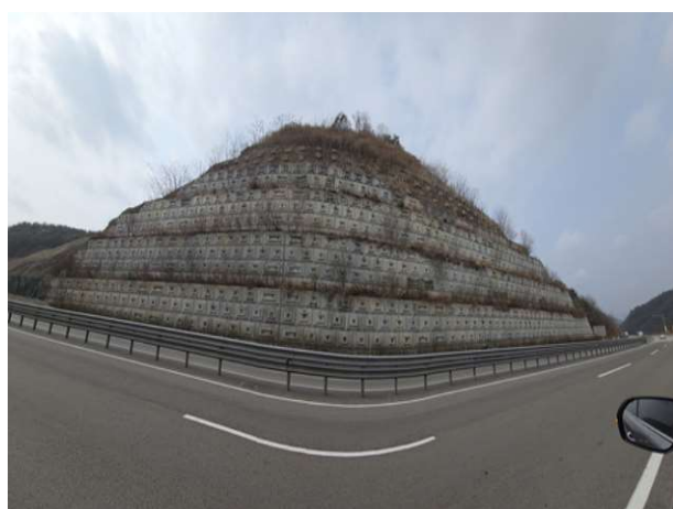
4공구 패널식 옹벽 05
