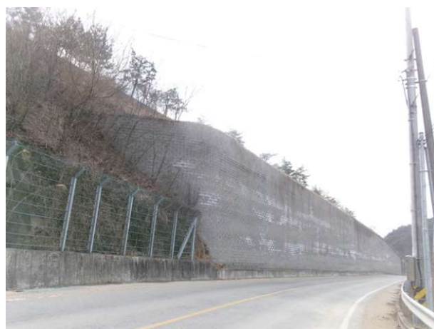
4공구 블럭식 옹벽 04
