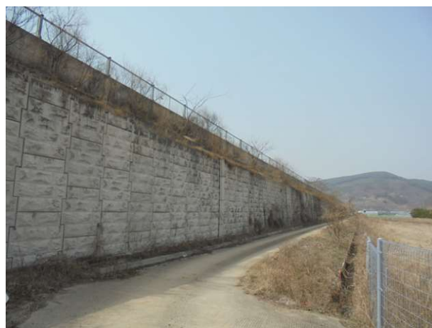
6공구 패널식 옹벽 08
