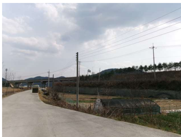
3공구 블럭식 옹벽 03
