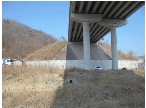
8공구 패널식 옹벽 14
