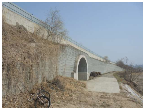
6공구 블럭식 옹벽 09
