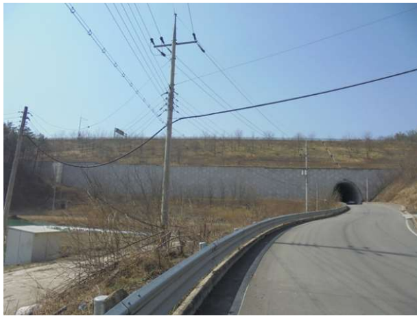
8공구 패널식 옹벽 13
