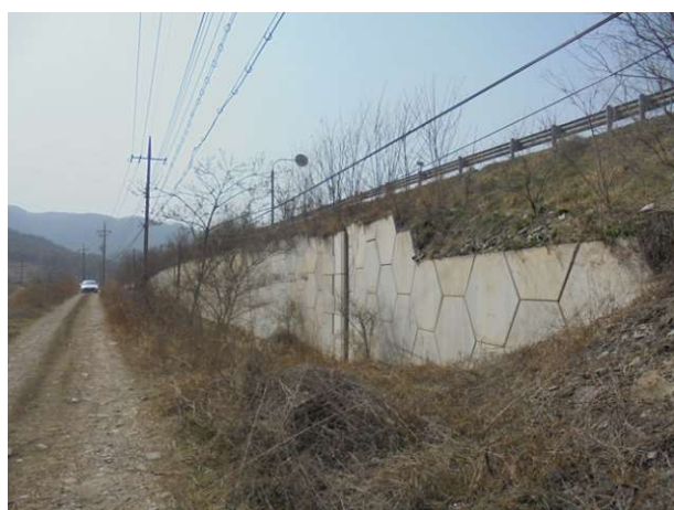
7공구 패널식 옹벽 11
