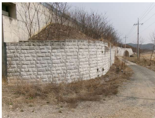
6공구 패널식 옹벽 07
